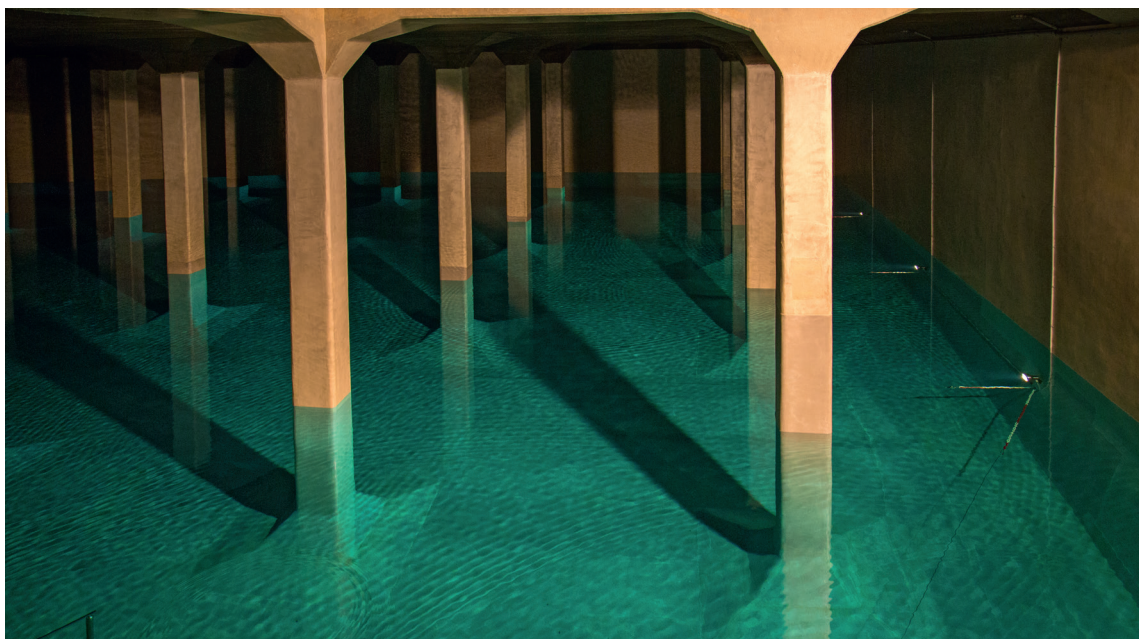
Gefülltes Reservoir mit eingebauter kathodischer Schutzanlage
