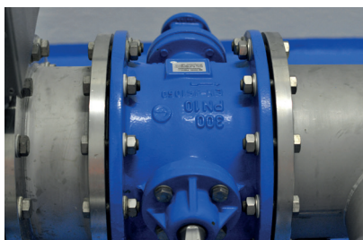
Válvula de fundición separada con casquillos aislantes
