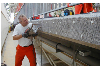
Montage du filet d'anode sur un sommier de pont
